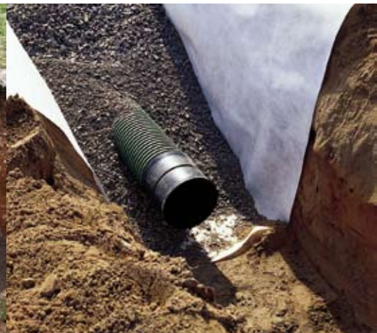
Výstavba zasakovací rýhy s drenáží
