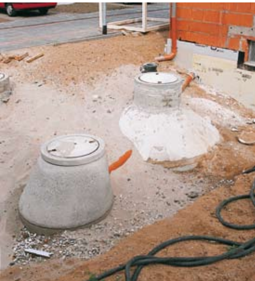
Filtr, zásobník na dešťovou vodu, zasakovací šachta
