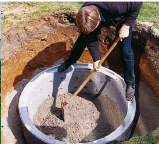
Výstavba zasakovací šachty
