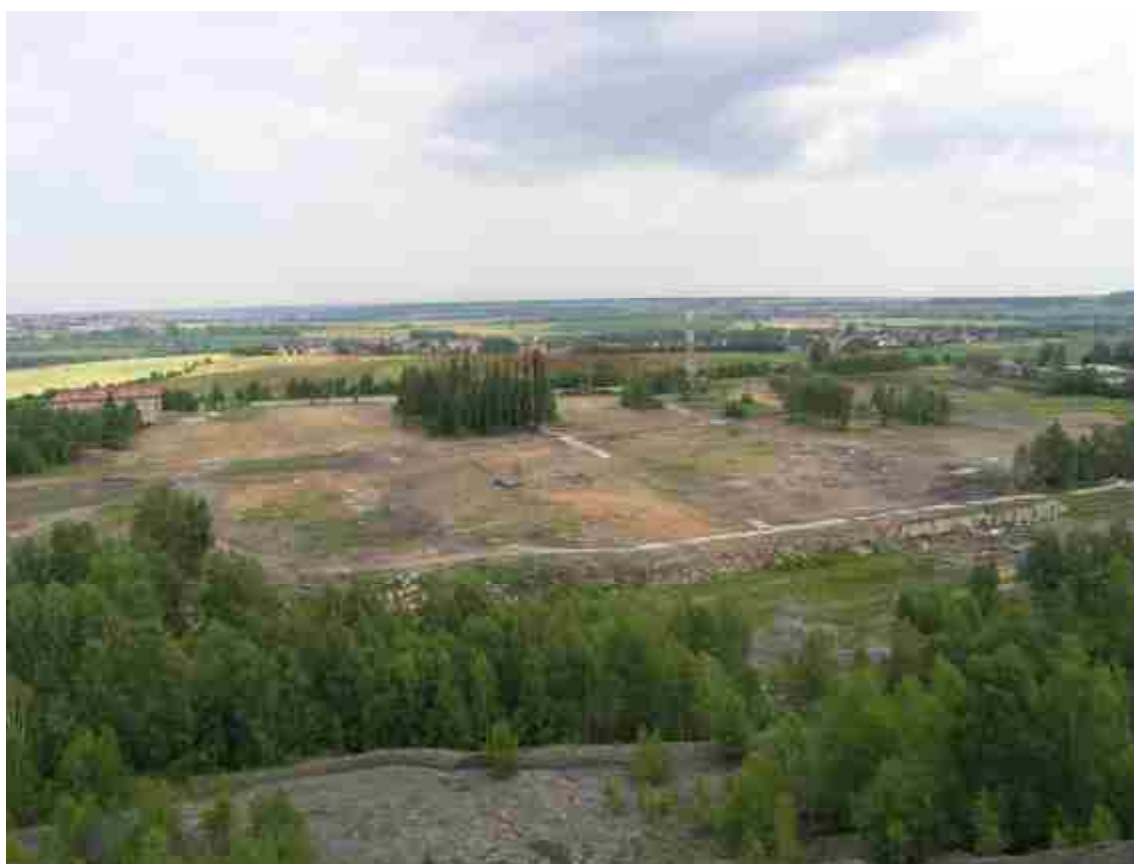
Obr. 10: Lok. č. 1 Tuchlovická halda, areál bývalého dolu připravený po sanaci terénu i objektů pro vybudování nové průmyslové zóny – příklad úspěšné revitalizace tzv. „brownfields“ (Foto: Tomáš Gremlica)
