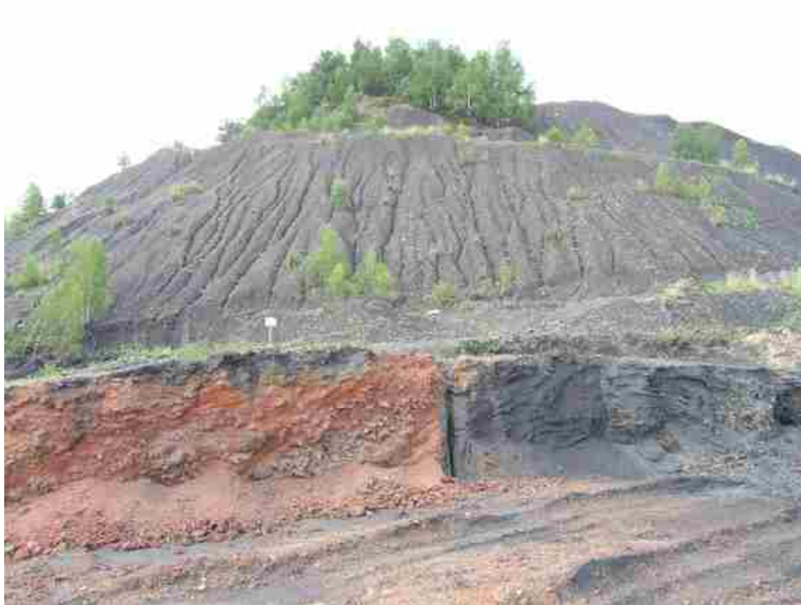
Obr. 19: Lok. č. 1 Tuchlovická halda, pohled na SV svah hlušinového odvalu s obnaženými vrstvami haldoviny, erozními rýhami a počínající ekologickou sukcesí (Foto: Tomáš Gremlica)
