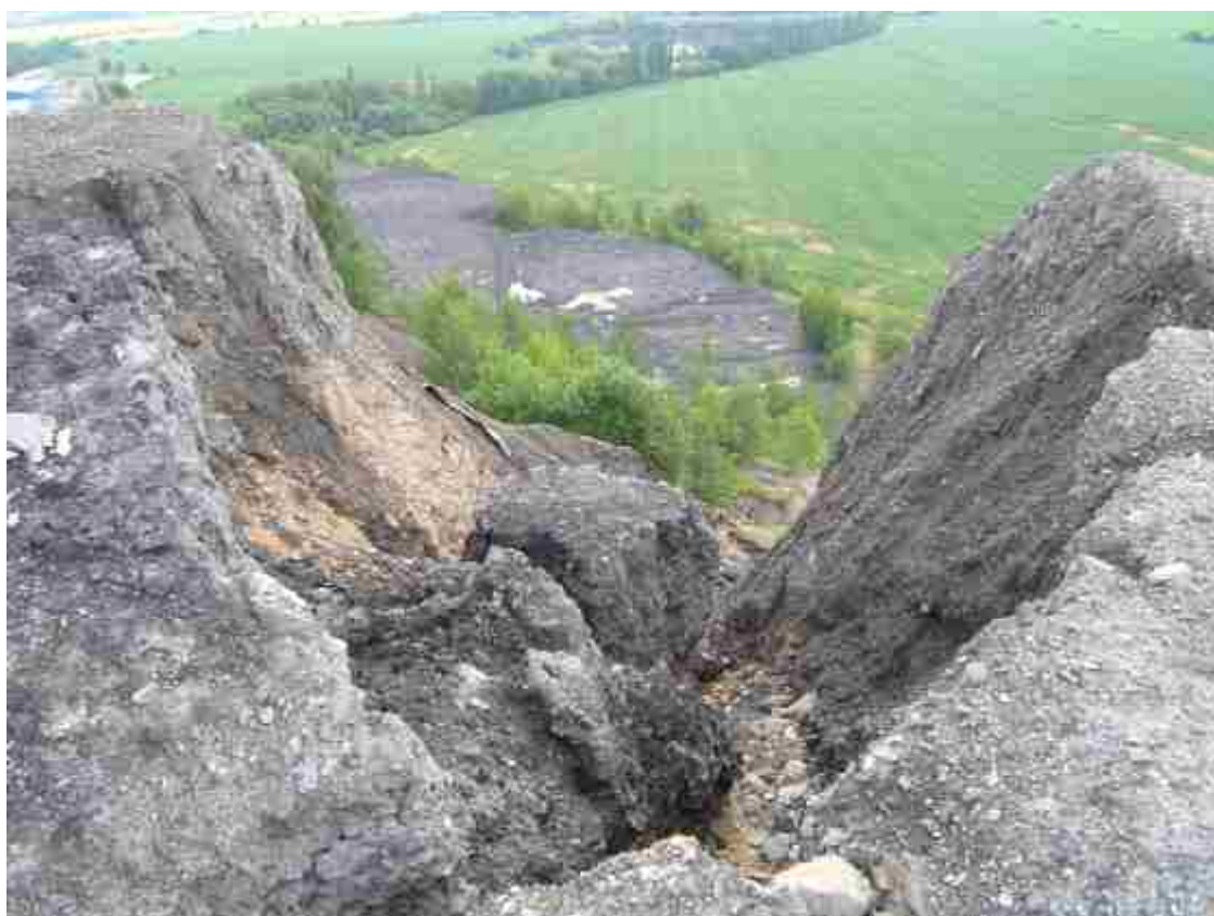
Obr. 17 a 18: Lok. č. 1 Tuchlovická halda, V svah hlušinového odvalu s erozní rýhou, jejíž rozměry jsou argumentem pro včasnou realizaci citlivě navržených a především kvalitně provedených protierozních opatření, která budou efektivně odvádět vodu z tělesa haldy (Foto: Tomáš Gremlica)
