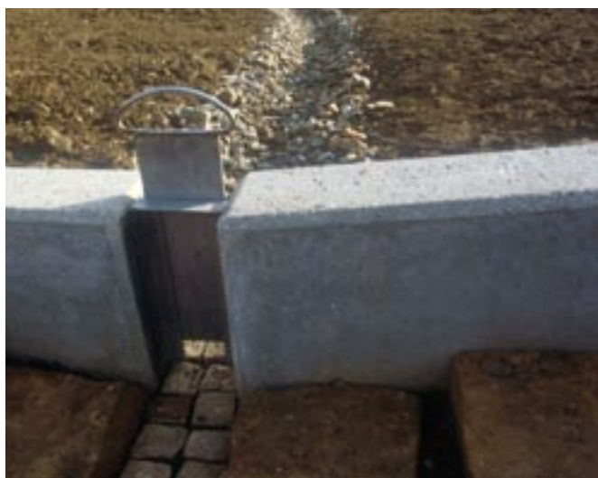
Obr. 47: Odtokové stavítko – viditelné, srozumitelné, se snadnou údržbou
