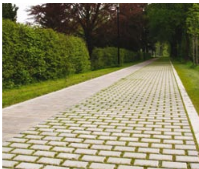
Obr. 27: Dlažba se zatravněnými spárami na méně frekventované cestě
