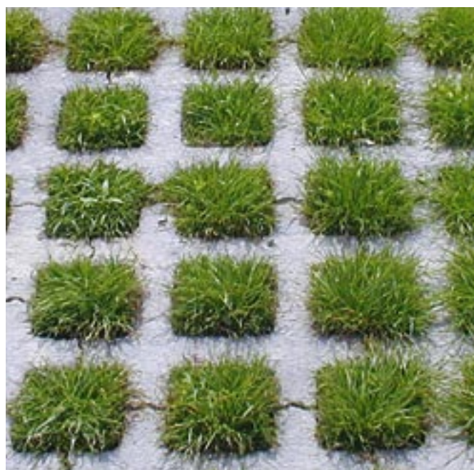
Obr. 8: Otevřené průduchy v povrchu umožňují odpařování a vsakování a zlepšují tak místní vodní bilanci.
