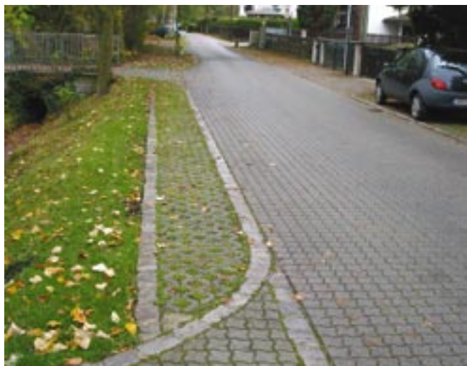
Obr. 70: Vede-li komunikace podél potoka, lze srážky zpravidla odvádět bez povolení. Vzorový postup aplikovali například zde v Gröbenzellu, kde voda může stékat do potoka přímo přes okraj komunikace.
