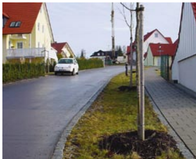
Obr. 75: Vsakování nepodléhající povolení v oblasti novostaveb na venkově často nebývá problém – tady v Ilmmünsteru stéká voda volně přes okraj komunikace do pásu zeleně a vsakuje zatravněnou horní vrstvou do půdy.
