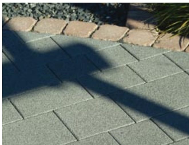
Obr. 31: Betonová dlažba z mezerovitého betonu
