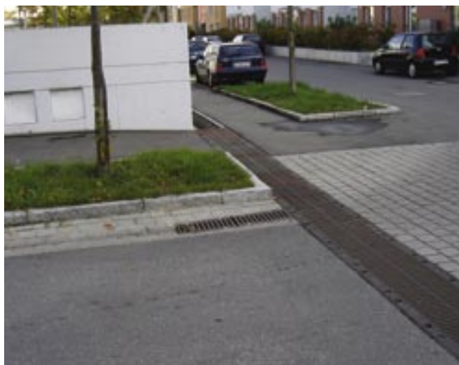
Obr. 43: Přechod krytého odvodňovacího žlabu na křižovatce
