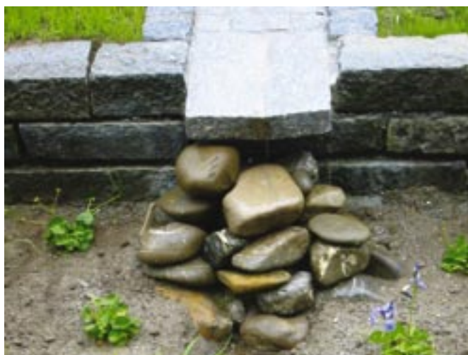
Obr. 84: Výtvarně pojaté ústí žlabu do vsakovací rýhy
