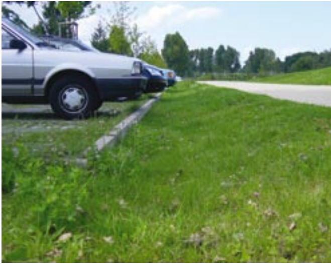
Obr. 60: Mělké vsakovací koryto za parkovacími místy – plošný přítok a plošné vsakování
