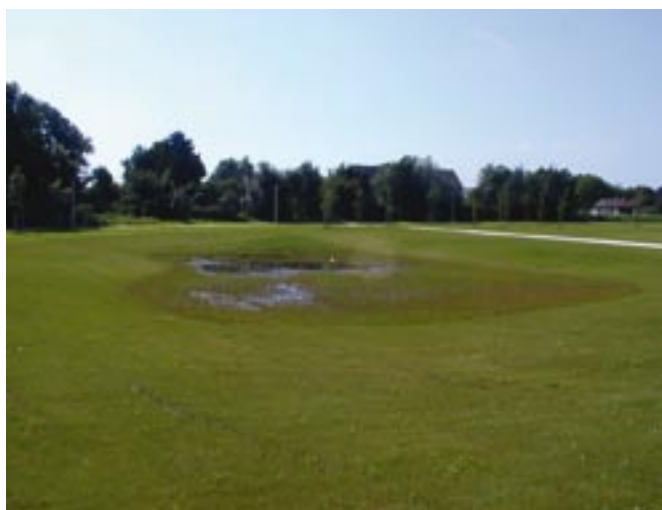
Obr. 49: Tady nevznikají žádné pochybnosti o bezpečnosti – retenční pánev s dočasně nahromaděnou vodou v kombinaci se vsakováním
