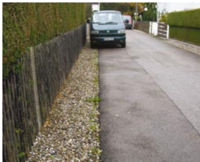
Obr. 78: Podzemní voda není dostatečně chráněna, pokud voda z komunikace zatížená škodlivými látkami vsakuje pouze vrstvou oblázků. Ty nejsou schopny odfiltrovat oleje, benzín nebo těžké kovy. Tyto látky se tak bez překážky dostávají do podzemní vody, především v případech, pokud je její hladina vysoká. Zatravněná horní vrstva půdy je nutným předpokladem pro plošné vsakování.
