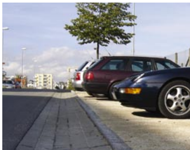
Obr. 42: K projektování bezpečnému z hlediska dopravy patří zajištění přejezdnosti rigolů.
