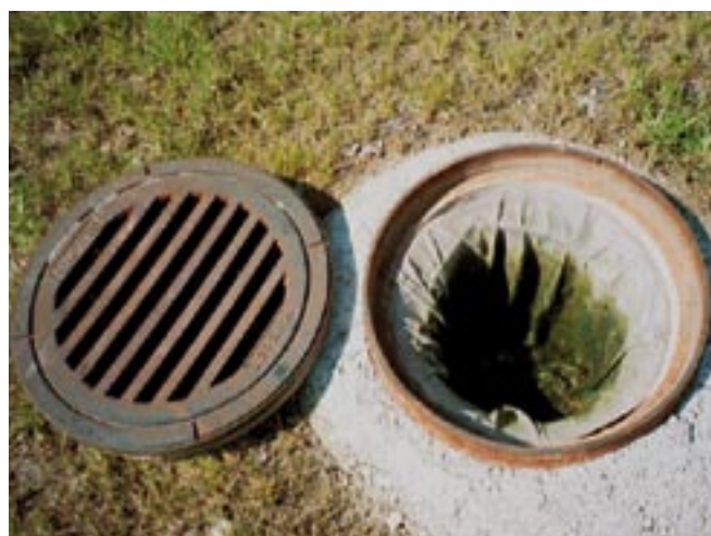
Obr. 57: Přelivná šachta s filtračním pytlkem zachycuje jemnější částice, její údržba je však nákladnější.
