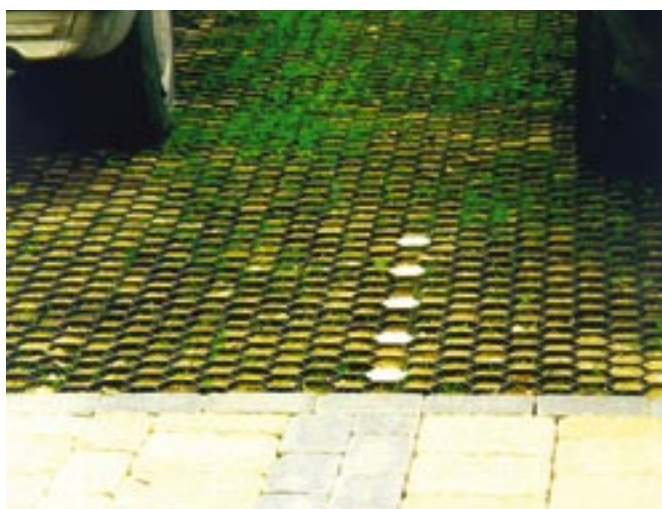
Obr. 28: Odstavná plocha s trávnickovými voštinami – s povrchovou protierozní ochranou (počínající zazelenění)
