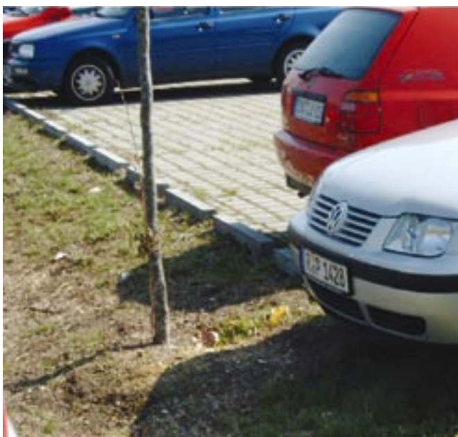
Obr. 74: Vsakování bez povolení je proveditelné i na velkých parkovištích jako třeba u odborné vysoké školy v Řezně. Pokud se nechceme vzdát obrubníků, lze náhradou místo uličních vpustí a potrubí vytvořit pomocí „zubů“ v metrovém odstupu přímý odtok přes okraj. Náklady na stavbu a provoz klesnou. Cestou přes zatravněný svah se znečištěná voda výborně pročistí. (Obrázek ukazuje nově postavené parkoviště s začínajícím zatravněním.)
