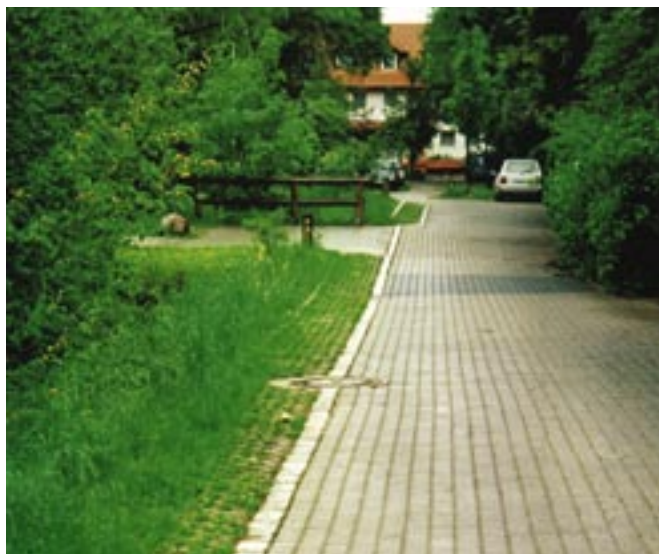
Obr. 67: Plošné vsakování v postranním pásu.
