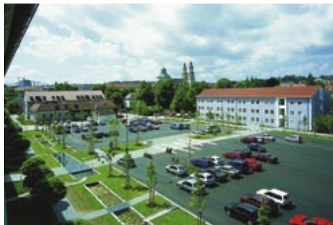
Obr. 10: Přírodě blízké odvodnění parkoviště a budov Státního úřadu pro pozemní stavitelství v Kemptenu
