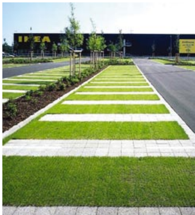
Obr. 37: Kombinace vegetačních dílců a dlaždic z mezerovitého betonu na parkovišti
