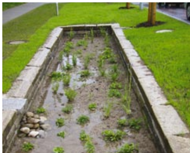
Obr. 53: Vsakování zatravněnou horní vrstvou půdy je možné i ve městě. Může se stát jako v tomto případě předmětem architektonického pojetí volných prostor. (Na obrázku: čerstvě osázené odvodňovací zařízení)
