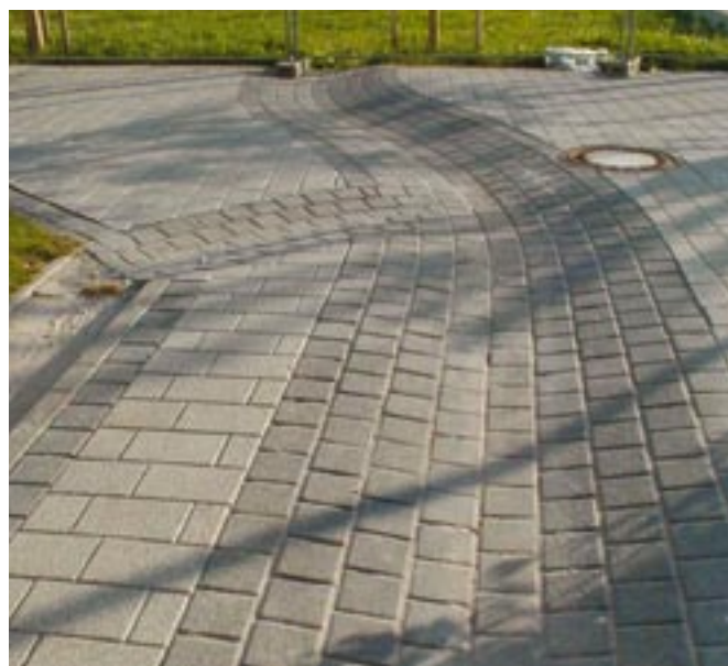
Obr. 73: Rigoly v obytných ulicích, v tomto případě na sídlišti „Am Rosensee“ v Aschaffenburgu, jsou levnější než dešťová kanalizace. Podporují odpařování, umožňují různé pojetí a zážitky z dešťové vody. Dlouholeté zkušenosti ukázaly, že rigoly nepřinášejí problémy ani v zimě.
