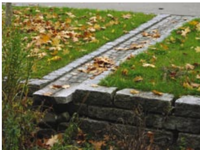
Obr. 15 Dlážděný rigol pro povrchové odvodnění
