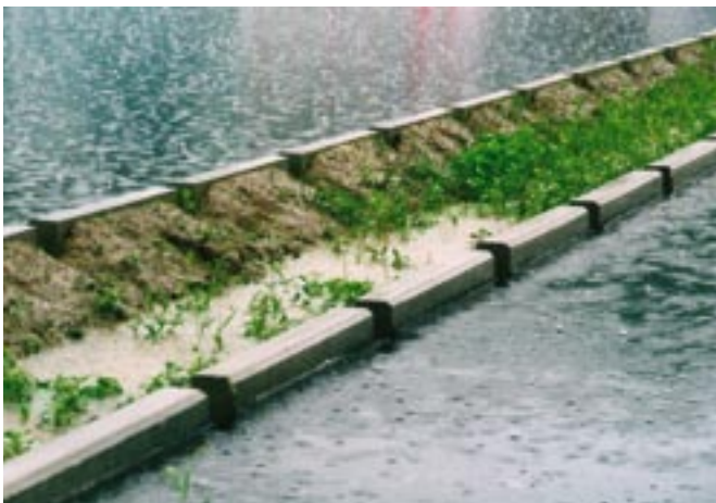
Obr. 23: Vsakování ve vsakovací rýze mezi dvěma parkovišti s asfaltovým povrchem. Při dostatečné vsakovací schopnosti podloží a předčištění v živých půdních zónách může vsáknout veškerá odtékající dešťová voda.
