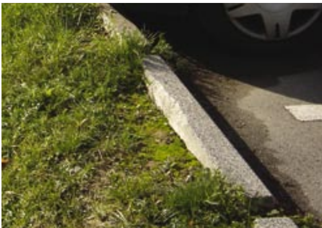
Obr. 21: Odvodnění pomocí mezer mezi obrubníky.
