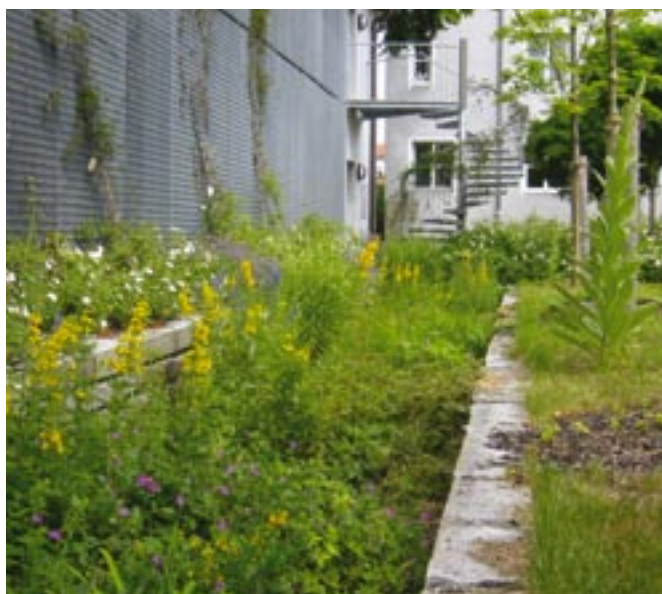
Obr. 81: Vsakovací rýha s porostem trvalek v 5. roce. Porostlá horní vrstva půdy tak zůstává stále propustná. Dvakrát ročně se plocha seče a kypří.
