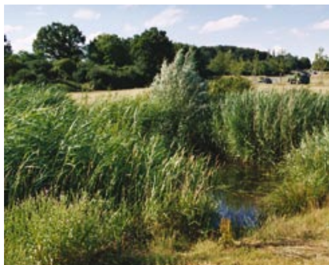
Obr. 55: Přírodně pojatý sedimentační rybník sloužící k čištění dešťové vody stékající z komunikace
