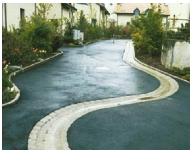
Obr. 41: Odvod dešťové vody dlážděným rigolem, který je architektonickým prvkem obytné ulice
