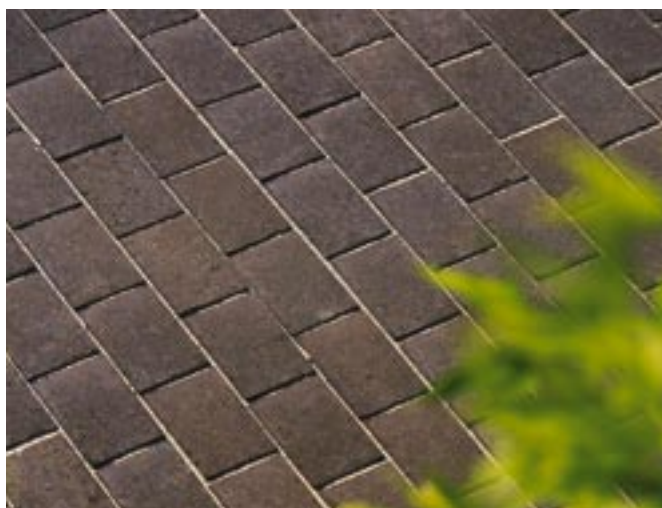
Obr. 30: Betonová dlažba s drenážními spárami
