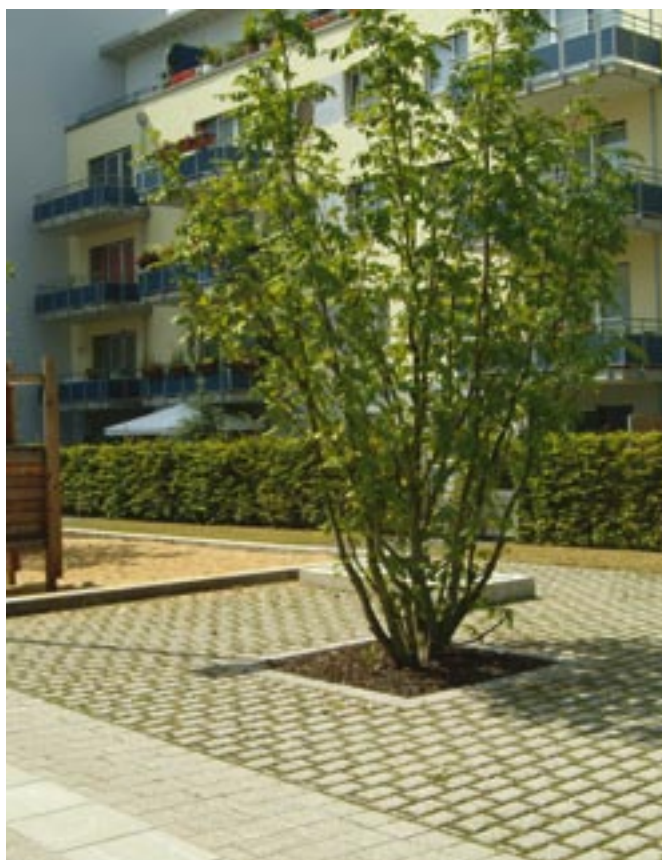
Obr. 34: Dlažba se zatravněnými spárami v prostoru dvora v obytné zóně
