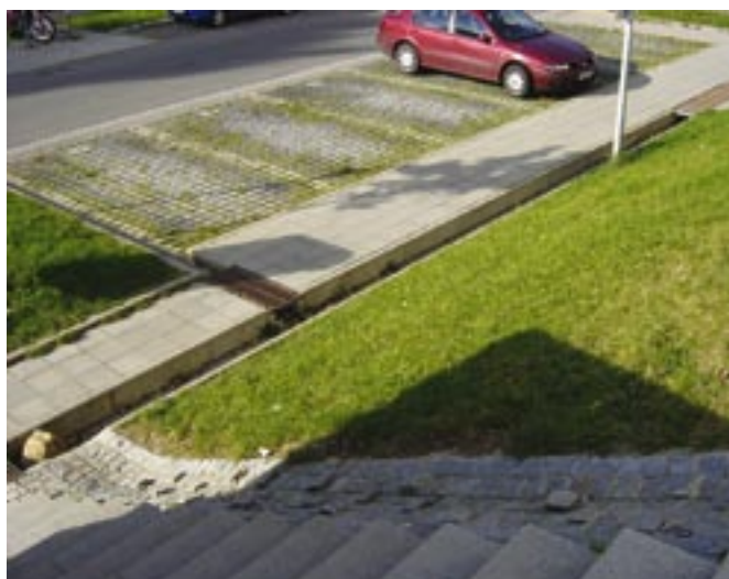
Obr. 87: Společný sběrný žlab pro parkoviště a vodu odváděnou ze střech
