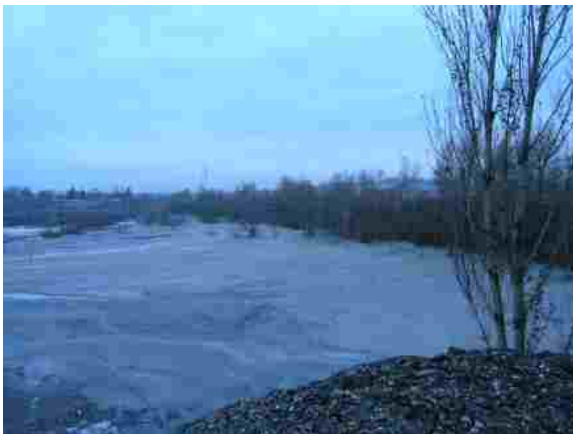
Obr. 51: Lok. č. 16 Ronna, pohled na úložiště kalů v pozdně podzimním aspektu (Foto: Tomáš Gremlica)
