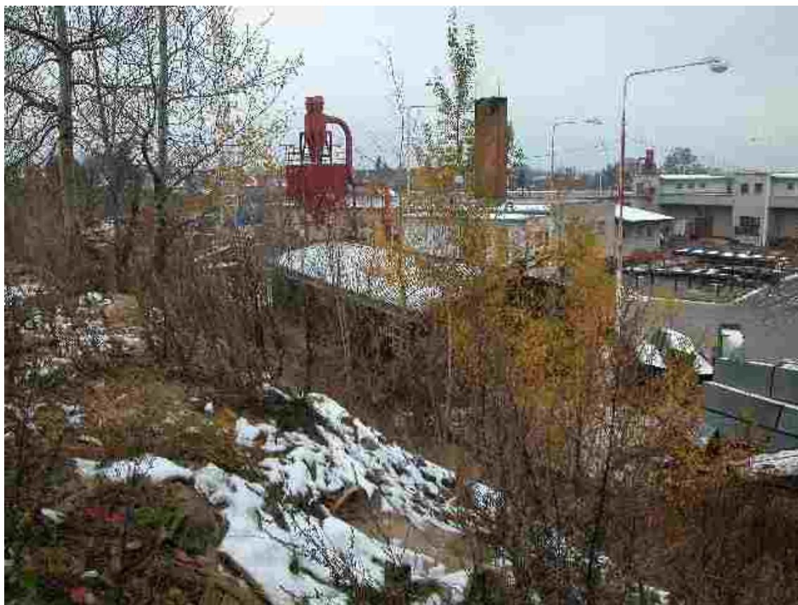
Obr. 58: Lok. č. 16 Ronna, ukázka bezprostředního kontaktu tělesa haldy s průmyslovým areálem (X1) (Foto: Ivo Příkryl)
