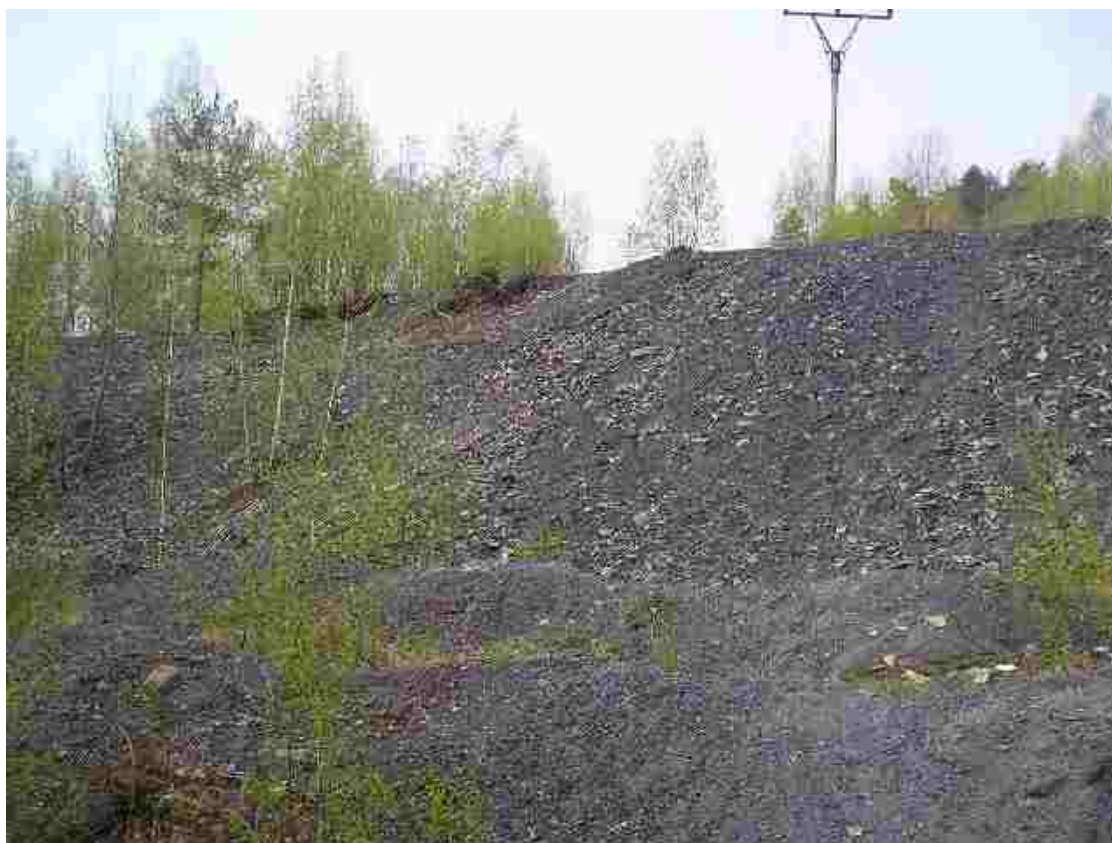
Obr. 112: Lok. č. 36 Felix-Jan, morfologie i materiál haldy brání rychlému vytvoření souvislého vegetačního krytu (Foto: OndřejVolf)
